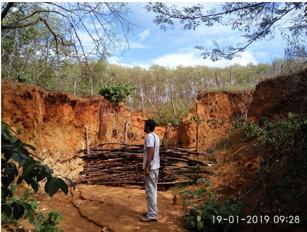
Figura 54 - Voçoroca situada em uma mancha de argissolo da Depressão Sertaneja
