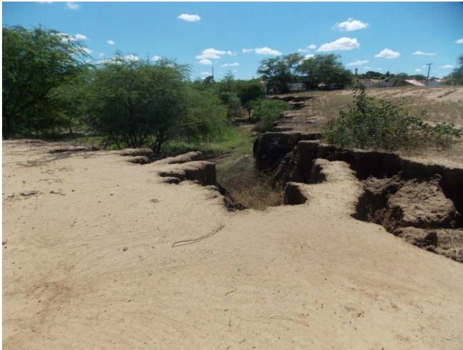
Figura 11: Processo de ravinamento na planície fluvial do rio Puiú decorrente da retirada da vegetação
