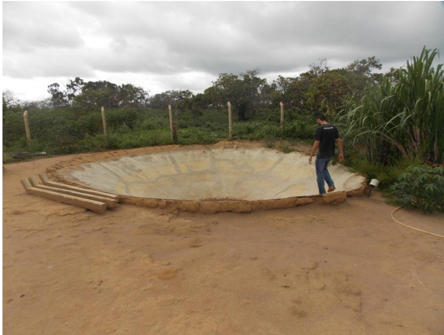
Figura 7: Barreiro feito de alvenaria para capturar água da chuva e impedir que esta infiltre no solo
