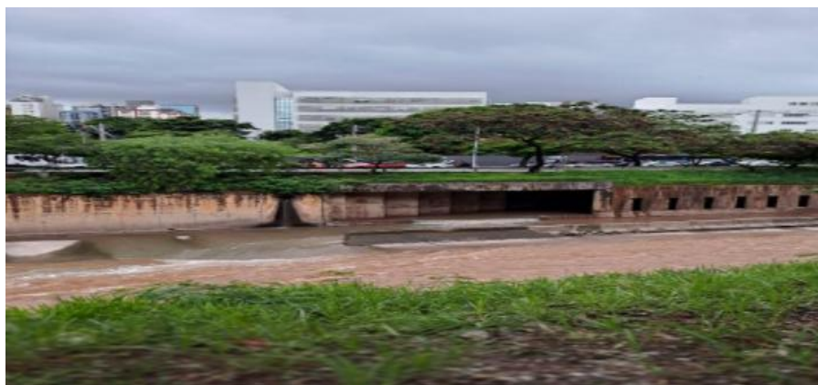
Figura 2: Córrego Leitão desaguando no Ribeirão Arrudas
