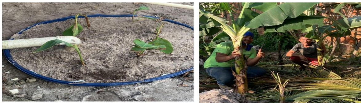
Figura 4 e 5- Construção do Círculo de bananeiras e de um TEvap em caixa de água
