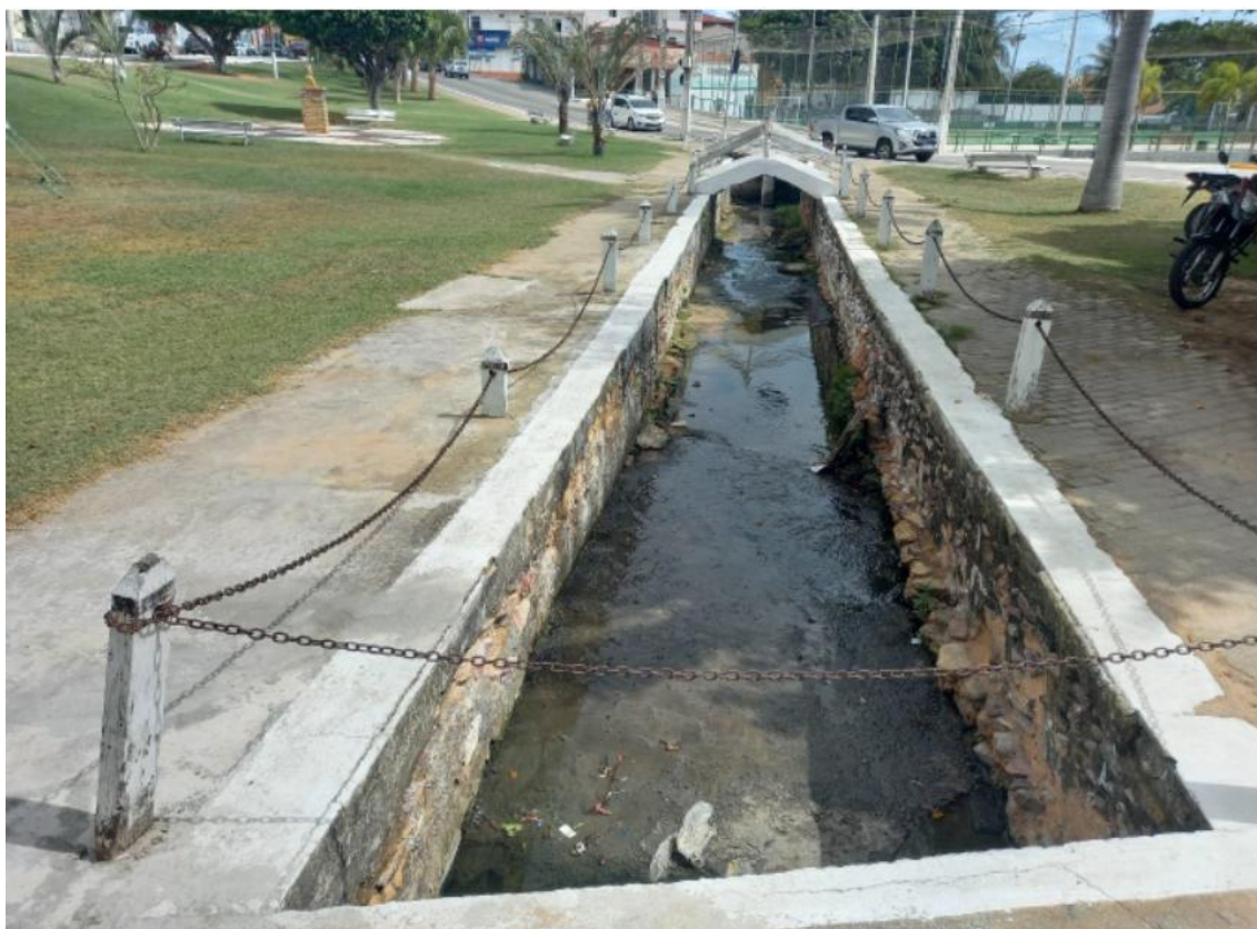
Figura 1: Canal de efluente no município de Fortim-CE.
